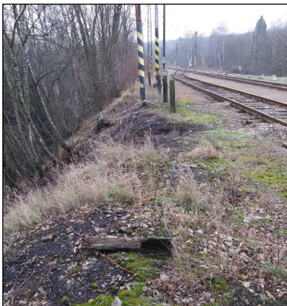
Foto č. 1: Sesuvy ve svahu násypového tělesa
