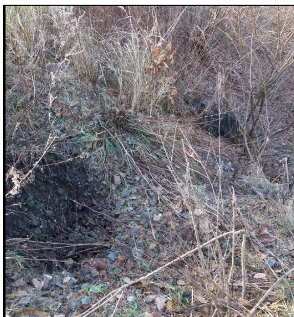
Foto č. 2: Povrchové projevy tvorby kaveren uvnitř násypového tělesa
